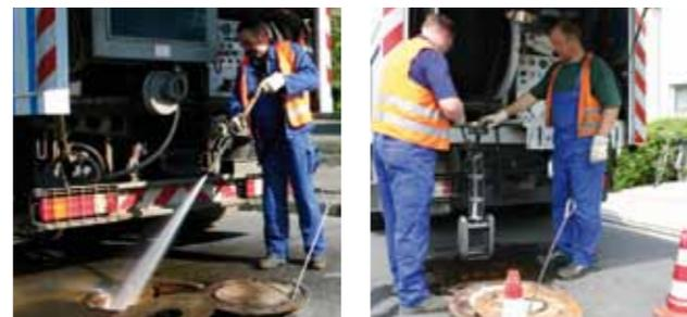
Je nach Ablagerungsart, -beschaffenheit und -menge sowie Größe der Rohrleitung und Wasseranfall im Kanal werden unterschiedliche Düsen eingesetzt. Ein Blick auf das ablaufende Spülwasser im Schacht genügt den erfahrenen Reinigungsteams in den meisten Fällen, um die Ablagerungssituation zu erfassen.
