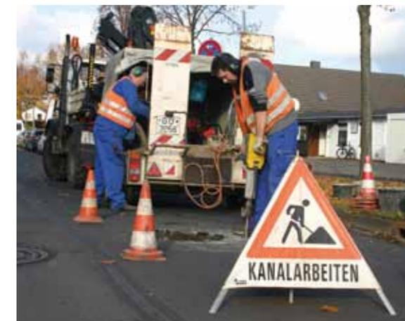
schnelle Abhilfe. In einigen Fällen können jedoch auch der Rahmen oder der Rahmenunterbau gebrochen sein. Hier schafft nur das Herausstemmen und Ersetzen des beschädigten Rahmens durch das Maurerteam des Kanalbetriebes Abhilfe.
