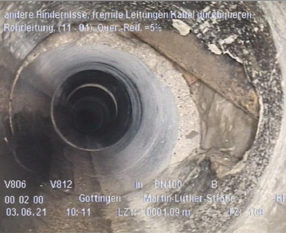
einragende Drainage
