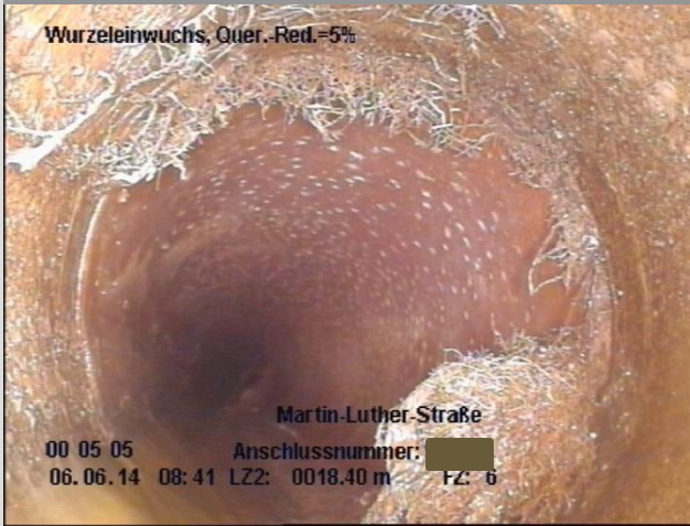
Einragender Anschluss
