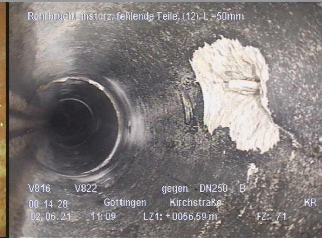
Abplatzung/ Boden sichtbar
