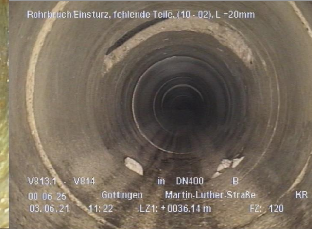
Abplatzung/ Boden sichtbar
